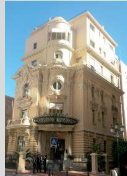
Bâtiment avant travaux
