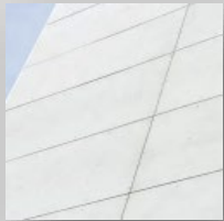
Panneaux d'enduit clair
