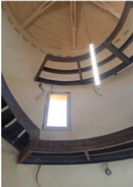
Travaux dans la tour
