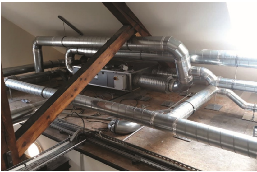
Le système de surventilation nocturne
