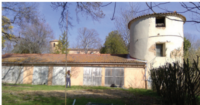
Le pigeonnier avant travaux
