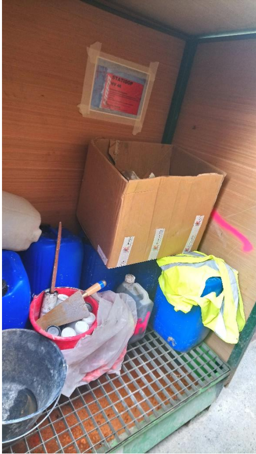
• Bac de rétention
