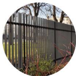
Clôture en serrurerie à barreaudage vertical (RAL 7016) (ajourée, pour permettre le passage de la petite faune)
