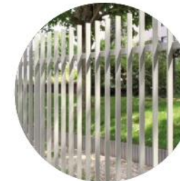
Clôture en serrurerie à barreaudage vertical (blanc) (ajourée, pour permettre le passage de la petite faune)
