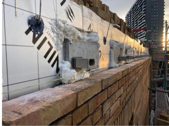
Nichoirs semi-intégrés dans l'isolation par l'extérieur
