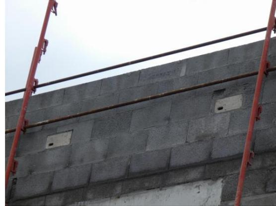
Nichoirs intégrés dans le béton
