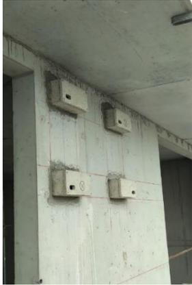
Nichoirs semi-intégrés dans le béton et semi-intégrés dans l'isolation par l'extérieur
