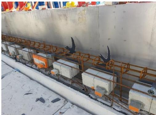
Nichoirs intégrés dans les banches avant coulage du béton
