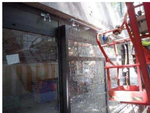
Essai d'aspersion sur baie vitrée au RdC.
