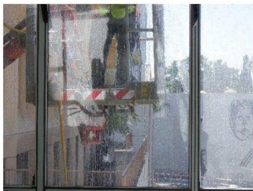
Essai en cours vu depuis l'intérieur au R+1.
