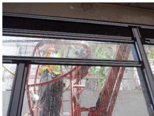
Essai en cours vu depuis l'intérieur au RdC.
