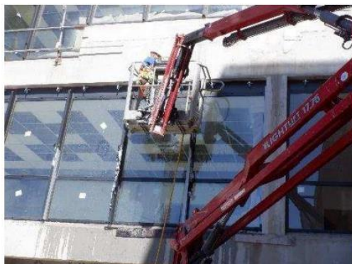
Essai d'aspersion sur baie vitrée au R+1.
