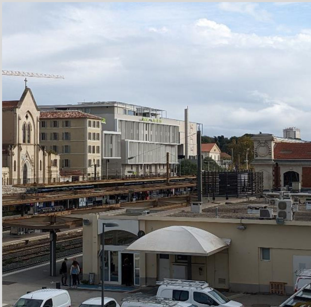
Vue depuis la gare (ouest)
