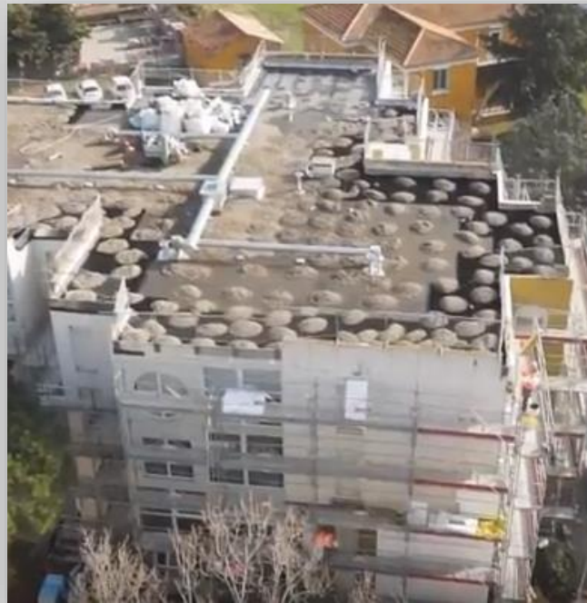
Etanchéité en toiture
