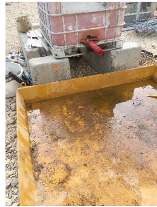
Bac sous huile de décoffrage à positionner. Plateforme basse
