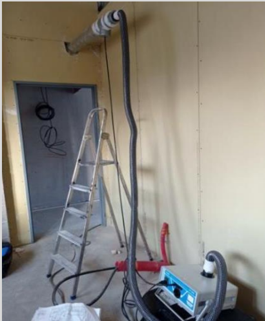
Essais perméabilité des réseaux ventilation classe B
