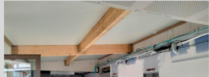
Charpente atrium en bois LMC (label PEFC)
