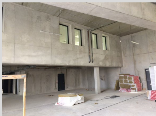
Vue niveau Mezzanine
