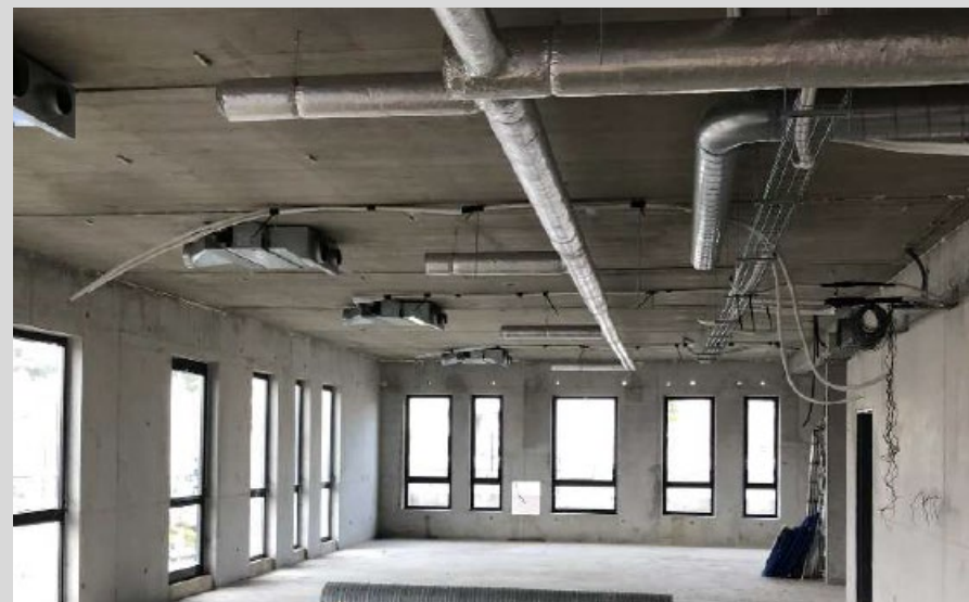
Pose des ventilo convecteurs
