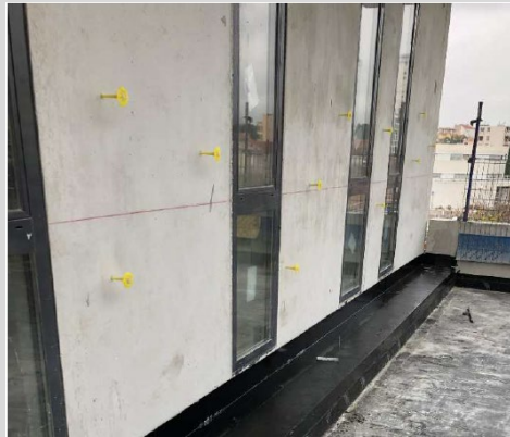
Fixation mécanique ITE
