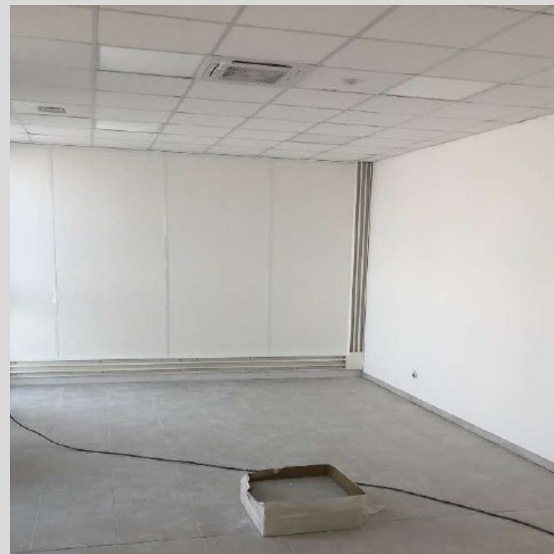
Revêtements murs (peinture), sol (carrelage), plafond (faux plafonds)
