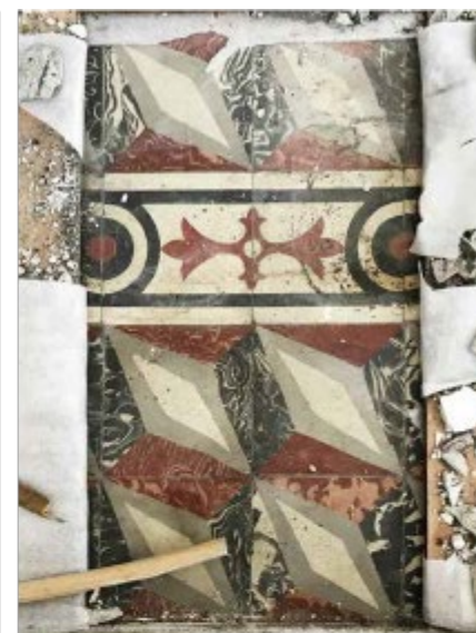
Carreaux de ciment découverts sous parquet stratifié > A119 Lgt 02
