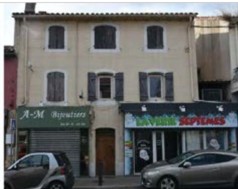
Façade Est existant
