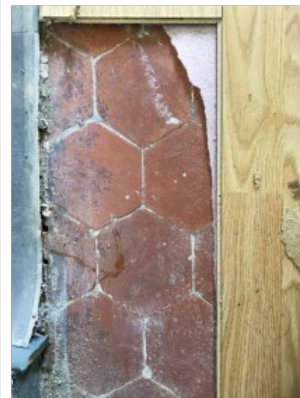
Tomettes découvertes sous parquet stratifié > A119 Lgt 03
