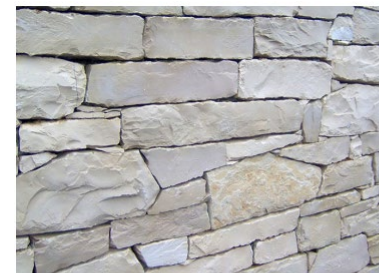
Mur en pierre sèche calcaire Hauteur : 0.70m Largeur : 0.40m
