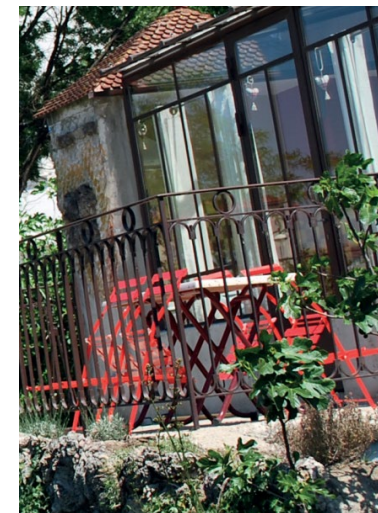
Châssis et garde corps en acier
