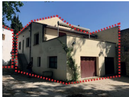
2. Bâtiment le long du chemin des Hors
