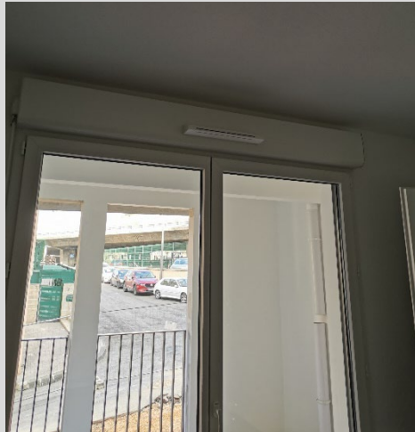
Entrée d'air hygro B, WC à double commande
