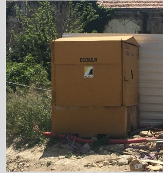
Photos - Bac de rétention huile de décoffrage & bac décantation laitances bétons
