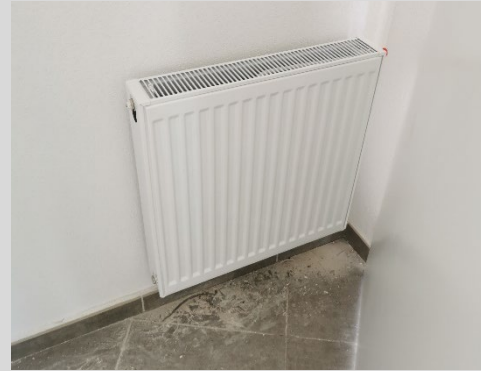
Radiateur à tête thermostatique Keymark + thermostat
