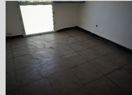
Passage de réseaux, rupteurs thermiques, couverture façade, carrelage
