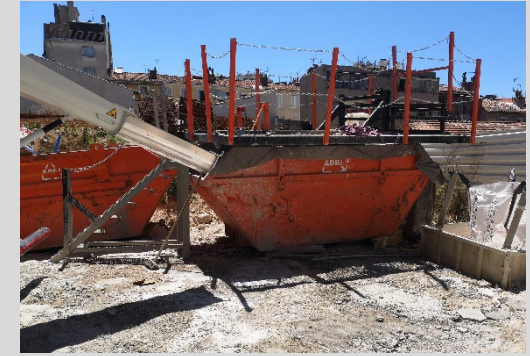
Photos - Bac de rétention huile de décoffrage & bac décantation laitances bétons
