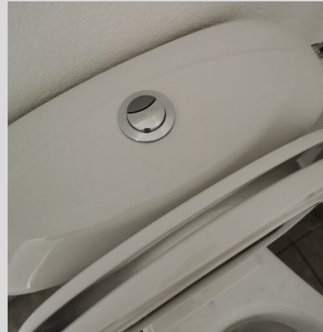
Entrée d'air hygro B, WC à double commande
