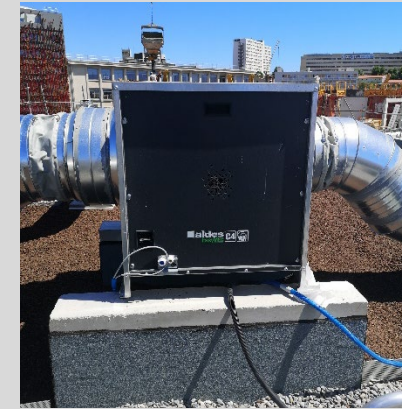
Végétalisation toiture et pose de bloc moteur ventilation
