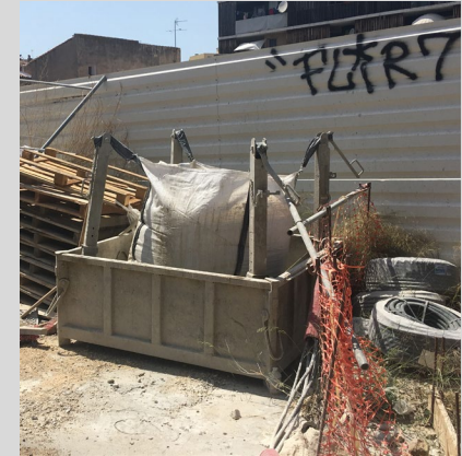
Bac décantation laitance béton
