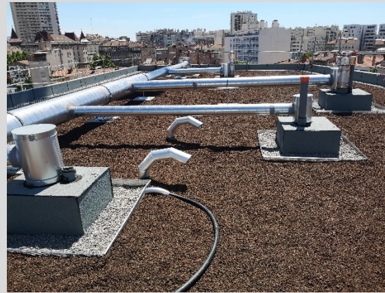
Végétalisation toiture et pose de bloc moteur ventilation
