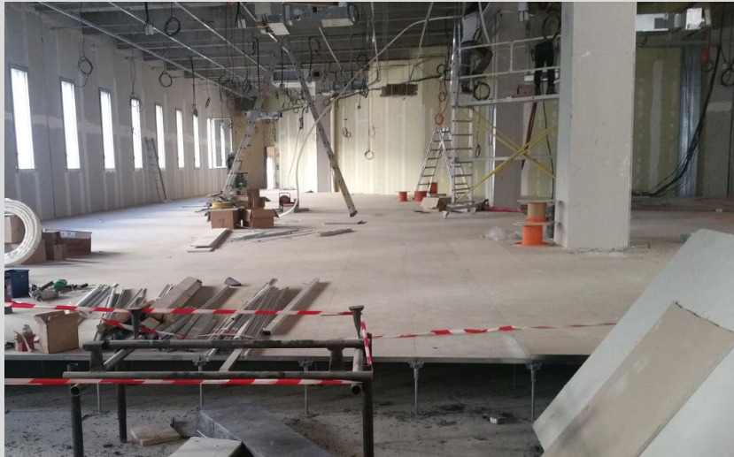
Pose des plancher bois surélevés (âme en bois aggloméré 30 cm)
