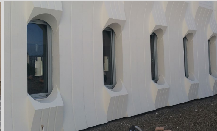
Dépose et remplacement des menuiseries existantes
