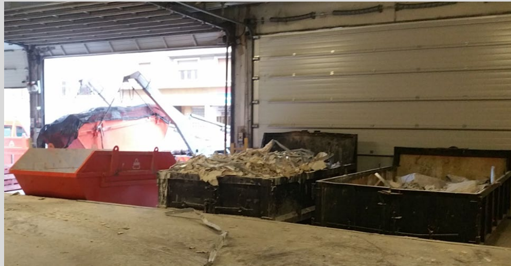
Benne DIB et bennes gravats en phase déconstruction (avec filet sur les bennes lors du transport )
