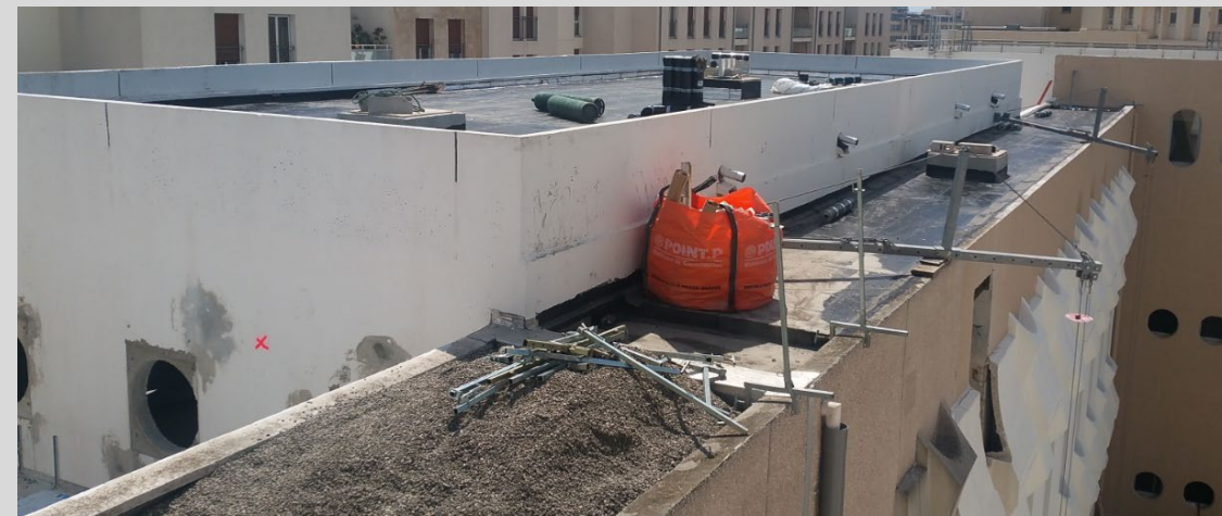
Mise en place de l'étanchéité sur isolant (support)
