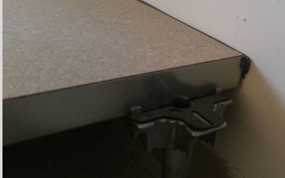
Pose des plancher bois surélevés (âme en bois aggloméré 30 cm)
