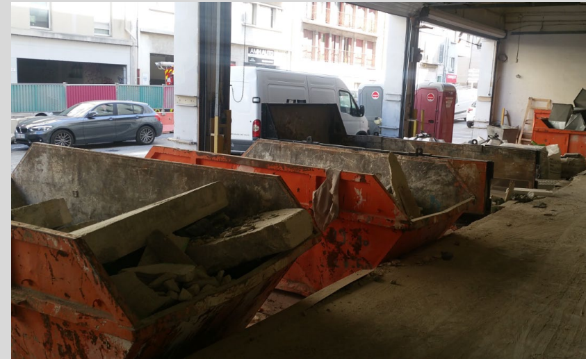
Benne DIB et bennes gravats en phase déconstruction (avec filet sur les bennes lors du transport )
