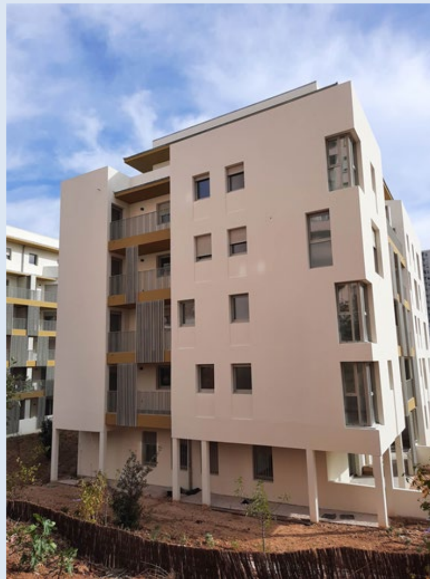
Ouest Bâtiment A
