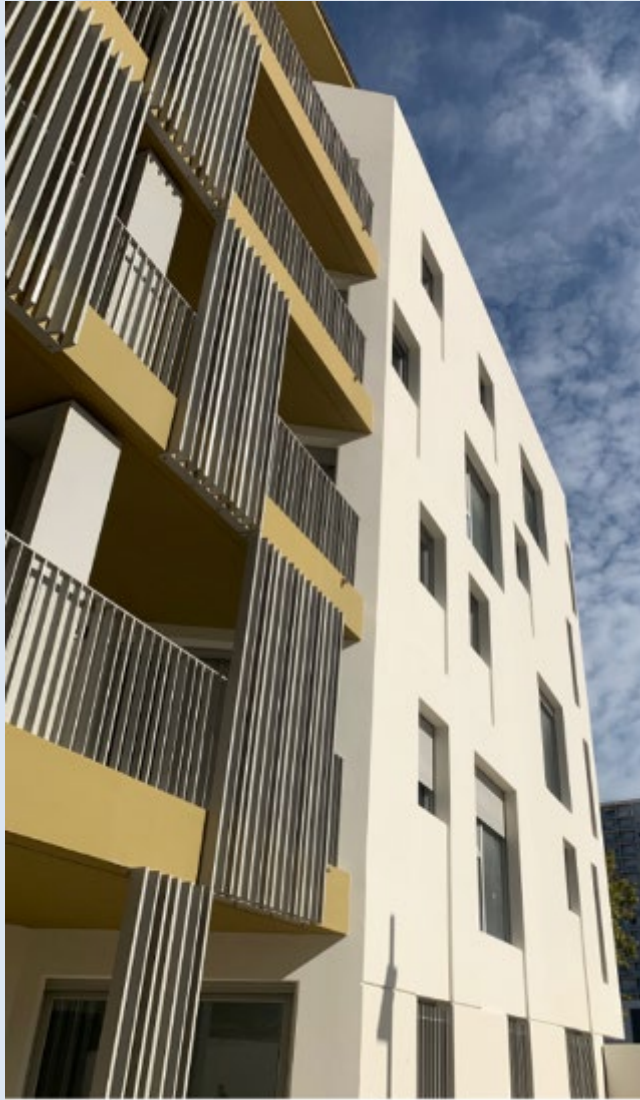
Est Bâtiment B
