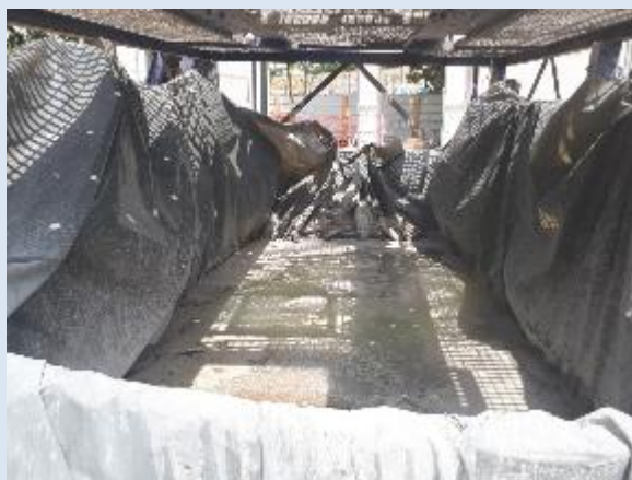
Zone de décantation des eaux béton
