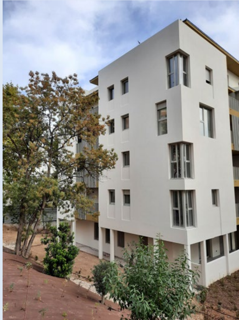
Ouest Bâtiment B
