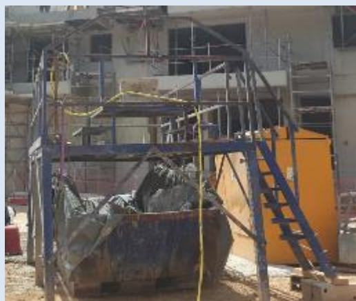
Zone de décantation des eaux béton
