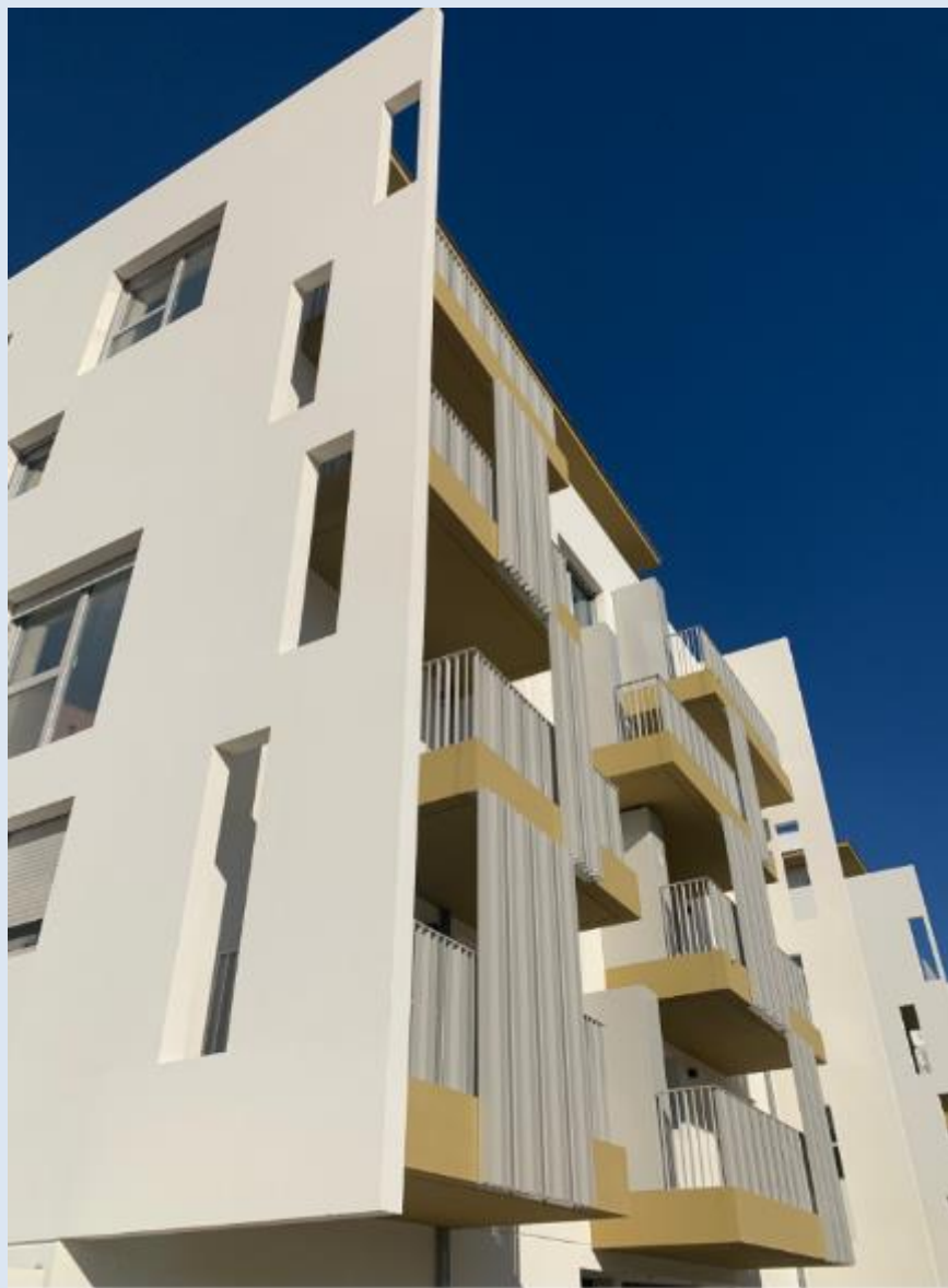
Est Bâtiment A
