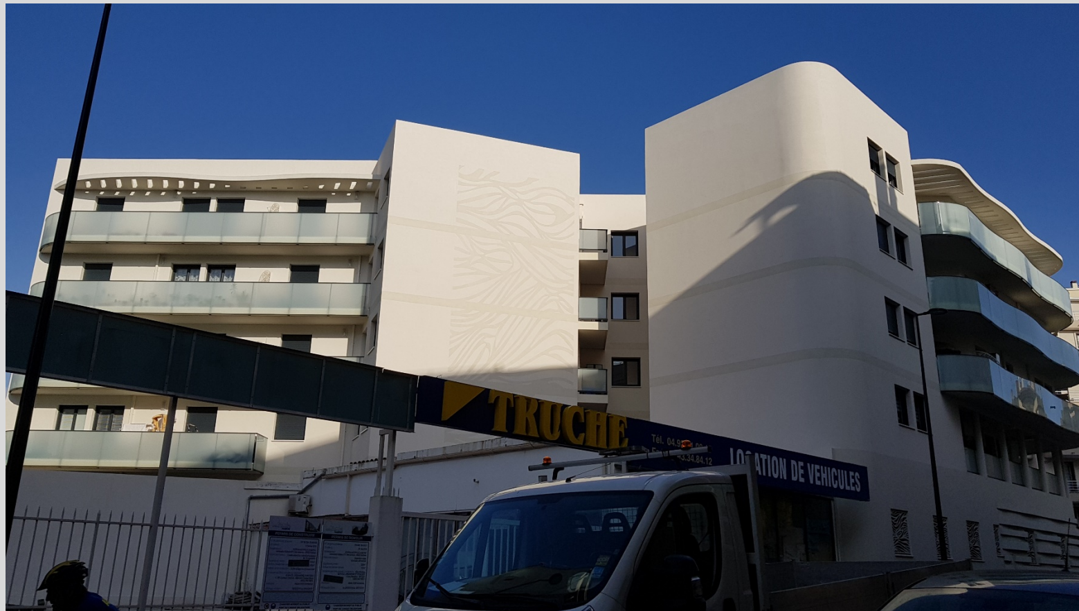
Vue des façades sud et Est
