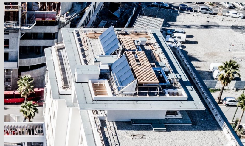
Panneaux solaires thermiques : 33 m 2
