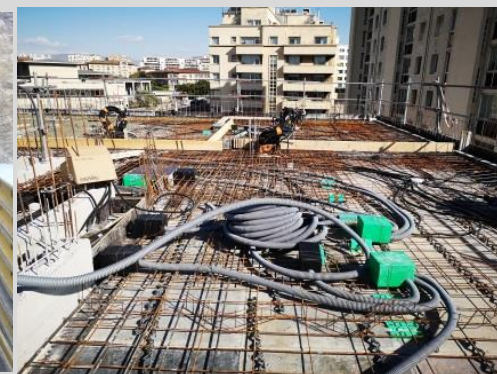
Benne en fonction - Installation gaines électriques
