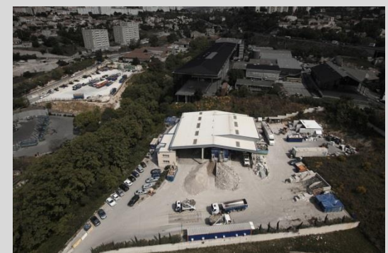
Photo Paprec Chantier 13
