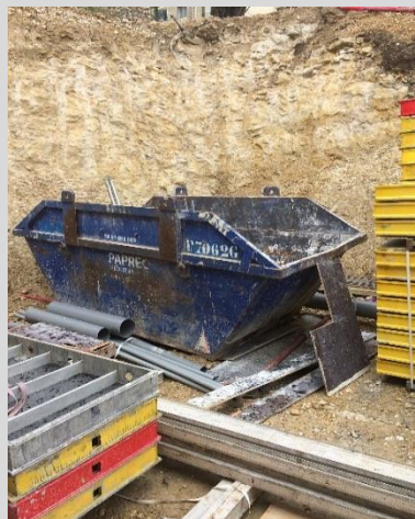
Installation benne tampon sur chantier
