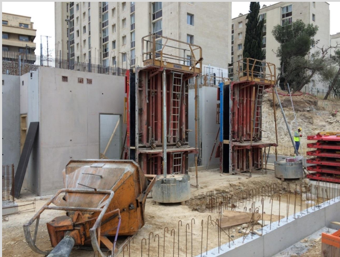
Photos - Bac décantation pour laitances bétons & bac de rétention huile décoffrage
