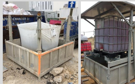
Photos - Bac décantation pour laitances bétons & bac de rétention huile décoffrage
