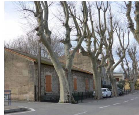
Vue du site avant le projet
