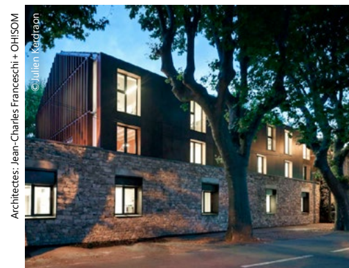
Vue du site après le projet
