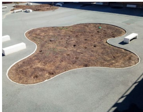
Vue du bassin à ciel ouvert
