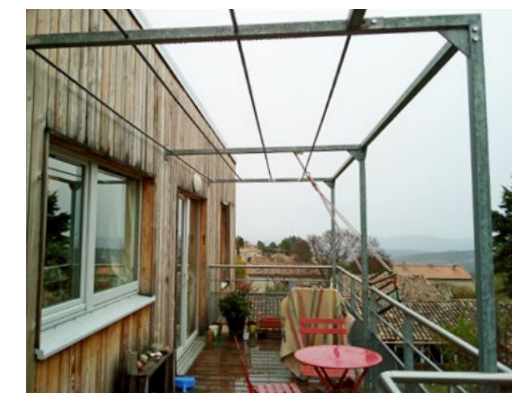
Structure porteuse d'une pergola grimpante
