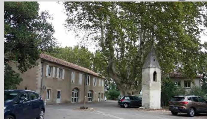
3. Pigeonnier (conservé) et Bâtiment 002 (à démolir)
