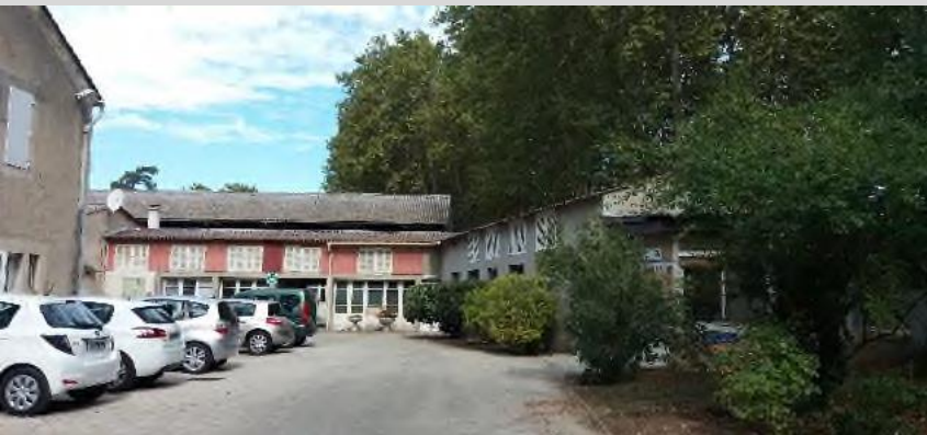
1. Bâtiment 020 – A démolir
