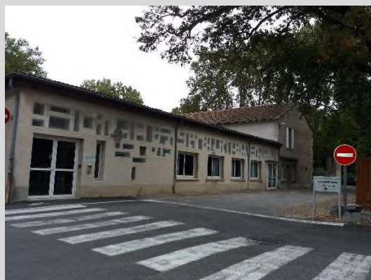
2. Bâtiment 004 (à démolir)
