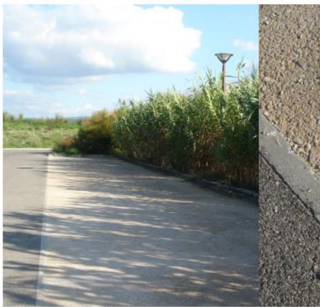
Stationnement en stabilisé
