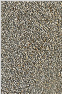
Allée de jardin en béton désactivé
