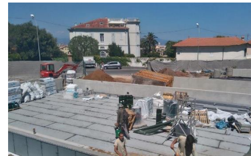
Bassin de rétention
