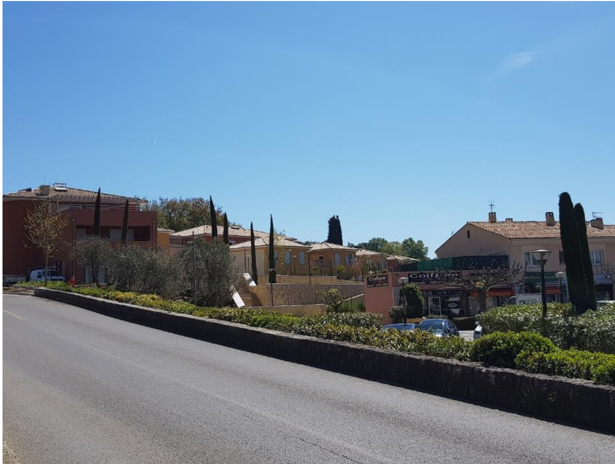
Vue depuis la route de Nice
