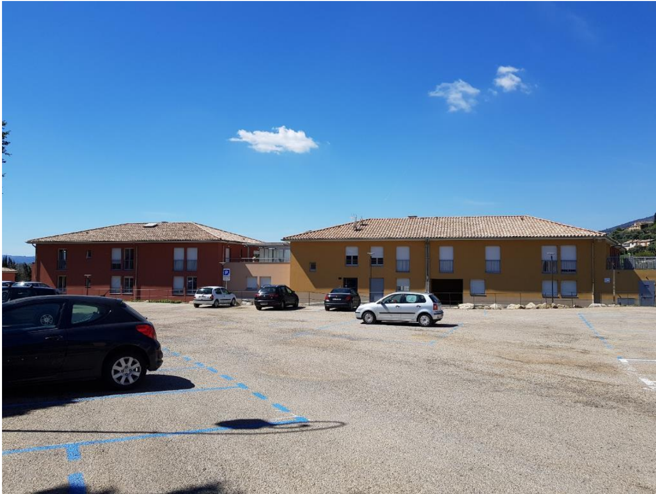
Façades Est Collectif
