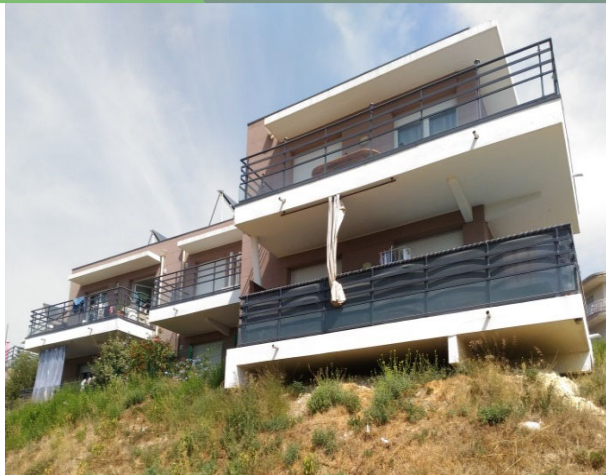
1. Vue sur la résidence « Les Hauts de Pessicart » ©EnvirobatBDM
