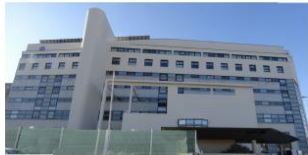
5 - La façade nord
