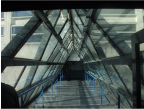
1 - Passerelle entre l'aile nord et sud au R+2
