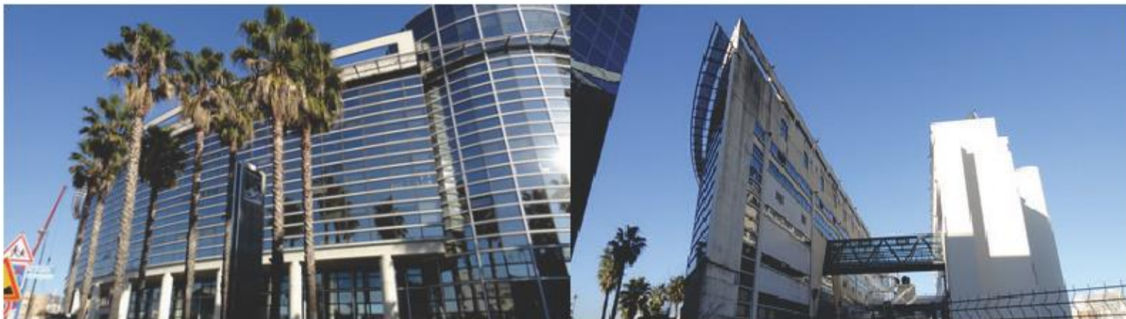
Façade Sud Sud Ouest bâtiment Sud
