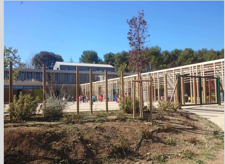
Cour maternelle et façade sud maternelle
