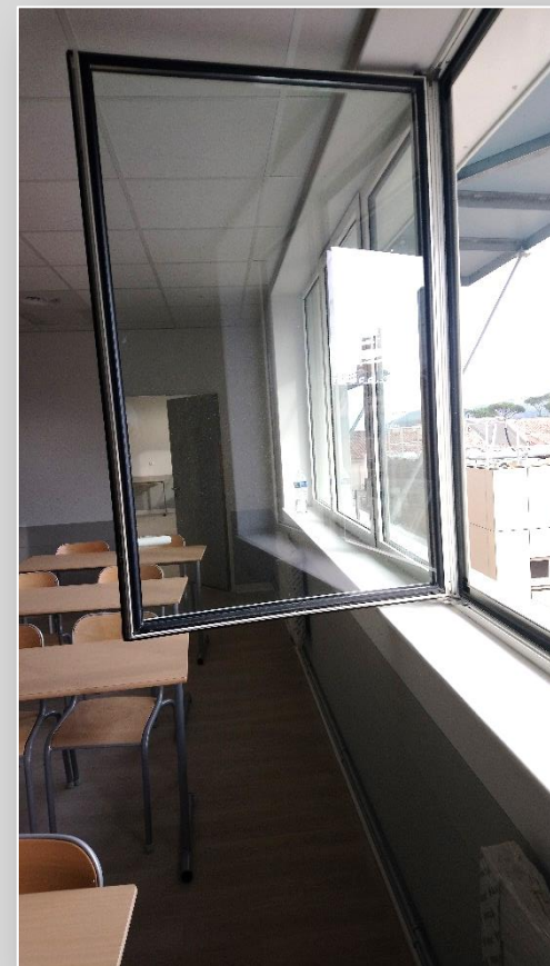
Menuiseries DV alu (PVC pour les logements)
