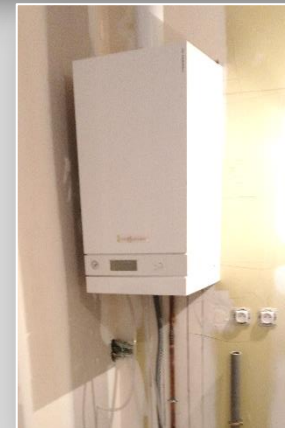
Chaudière gaz individuelle à condensation pour les logements VIESSMANN Vitodens 17,4 kW
