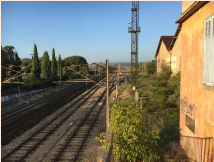
Parcelle accolée à la voie ferroviaire
