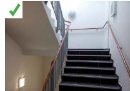
Luminaire en partie sombre allumé et luminaire en partie éclairé éteint Sectorisation - Projet 2. eaqc
