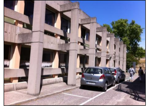
Façade Est bâtiment enseignement
