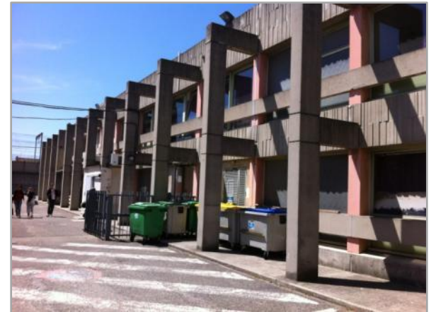
Façade Ouest bâtiment enseignement
