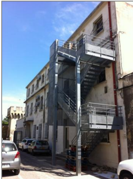
Façade Ouest bâtiment administration
