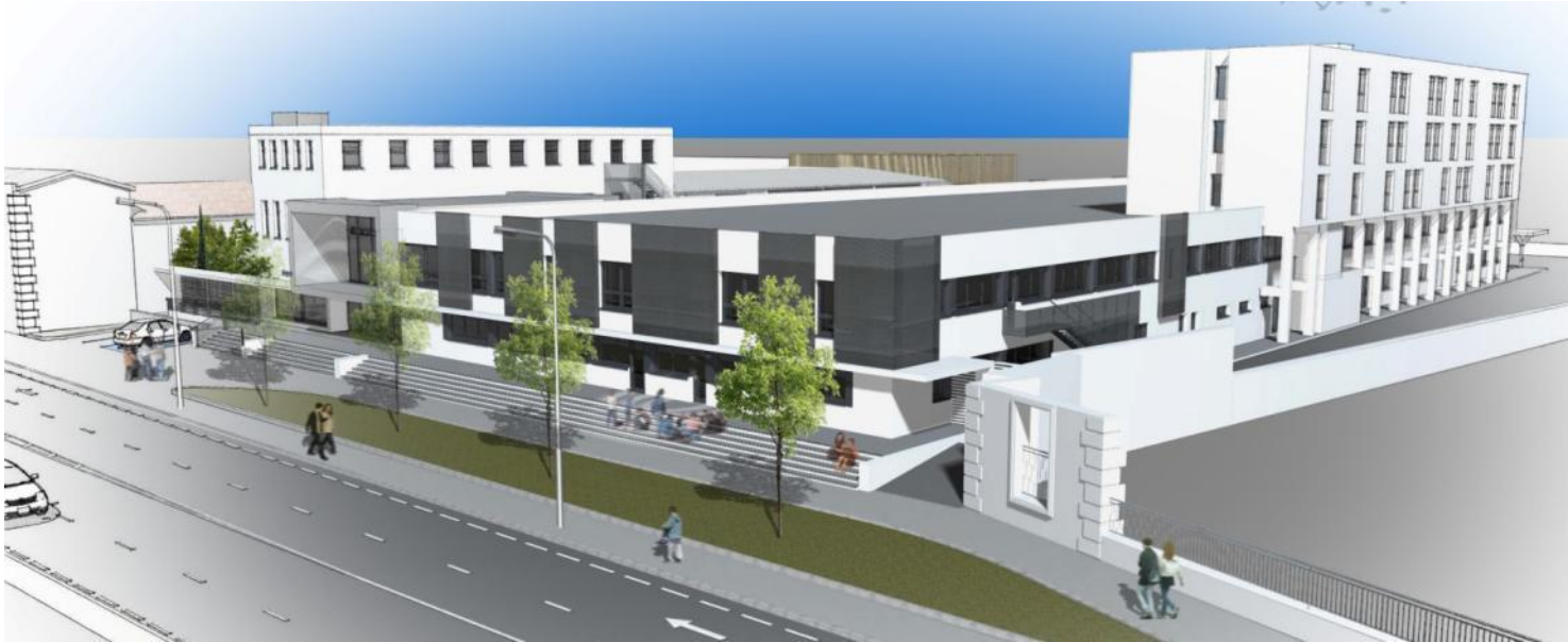
Façades Nord et Ouest
