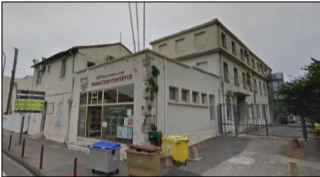
Façade Nord bâtiment administration
