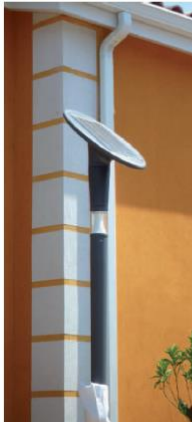
Mat d'éclairage solaire
