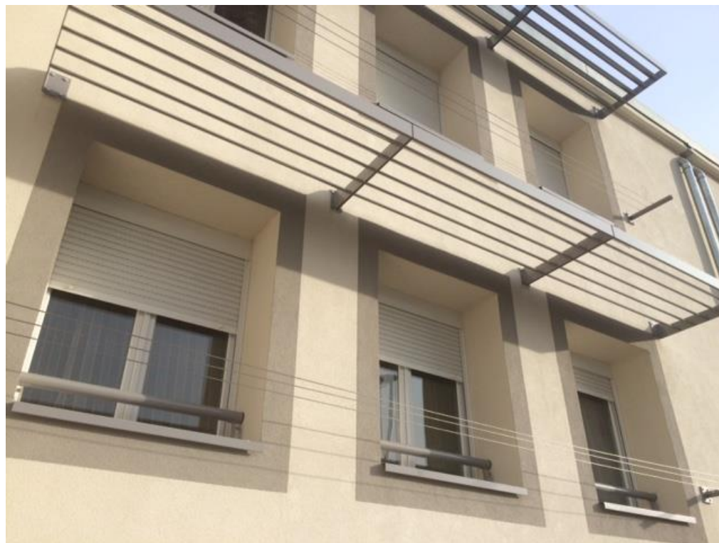
Pose des brise-soleils et étendages
