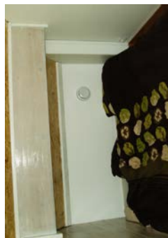
▲ Positionnement inadapté d'une bouche d'insufflation de ventilation DF créant de l'inconfort
