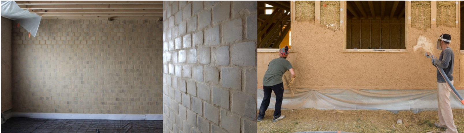
IZUBA: La mise en œuvre de la terre - briques et enduit
