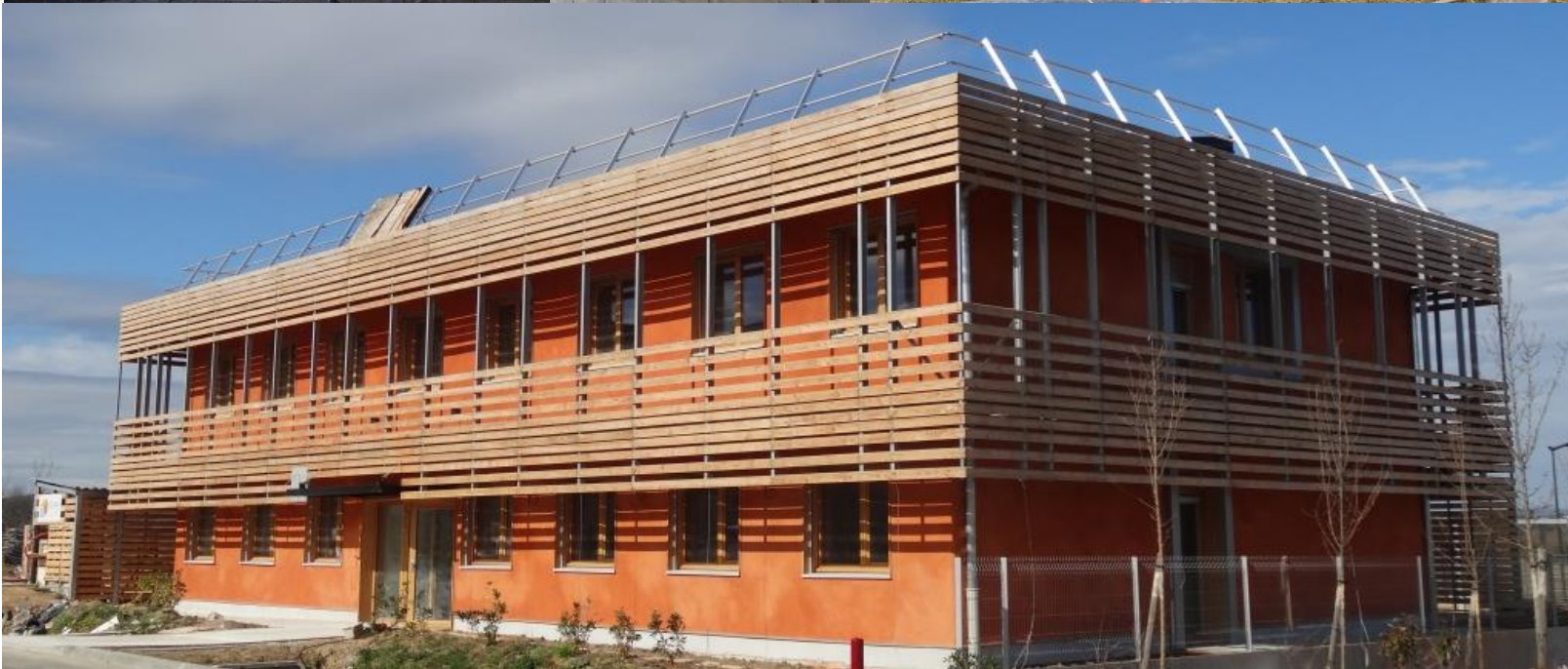
IZUBA: vue générale du bâtiment
