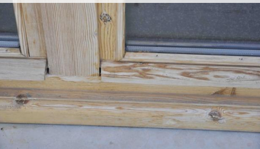
Groupe scolaire - RUSTREL - Menuiseries
