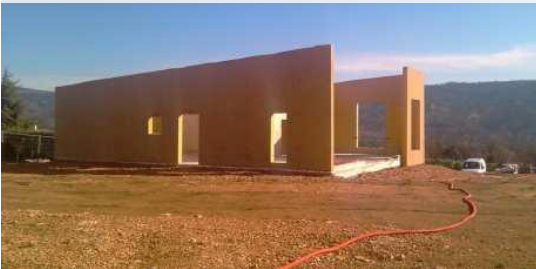
Groupe scolaire – RUSTREL - Ossature
