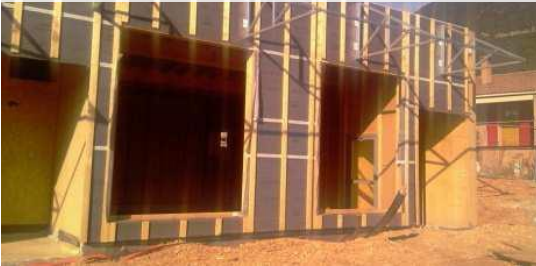
Groupe scolaire – RUSTREL - Ossature
