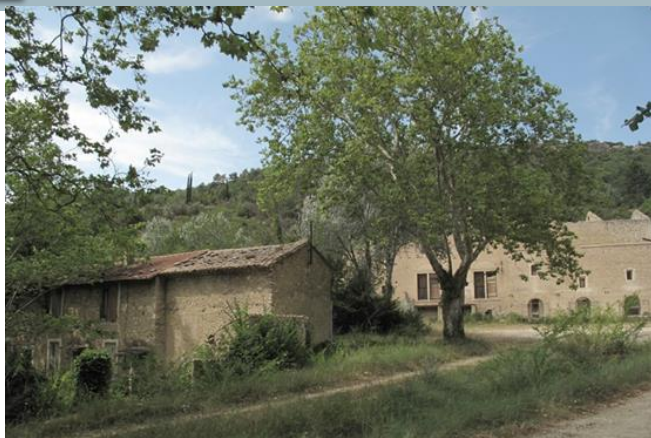
LES PATRIERES – Les bâtiments existants
