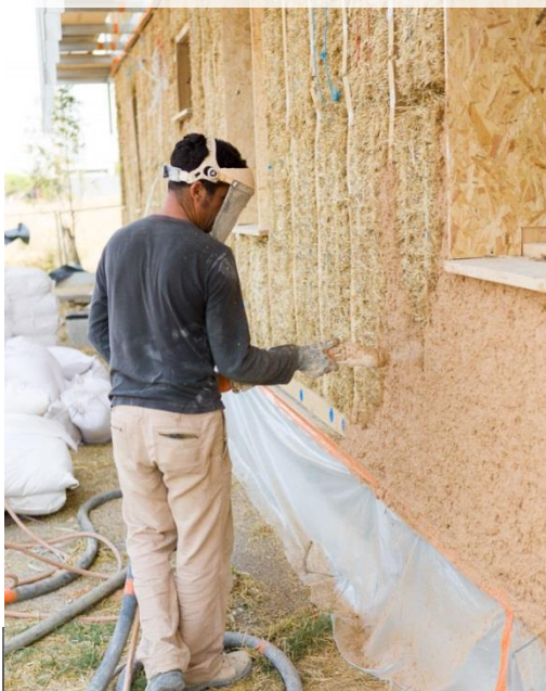
IZUBA - Mise en œuvre de la paille
