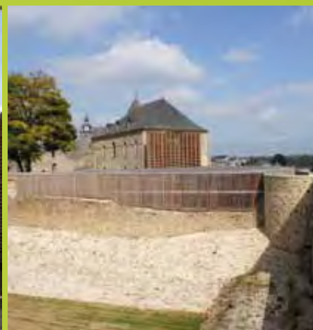
L'adjonction discrète du bâtiment contemporain, qui utilise largement le chêne de la filière locale. Un puits canadien court le long de l'extension. La lumière naturelle est omniprésente.
