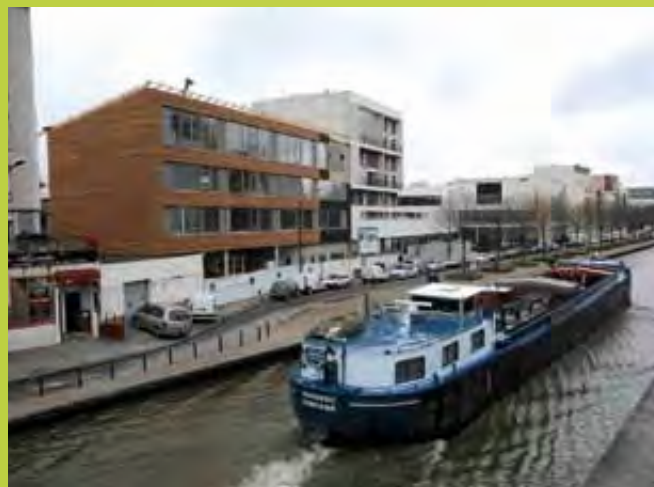
Vue façade Nord sur canal. Les classes élémentaires donnent au Nord et sont distribuées par des circulations côté Sud.
