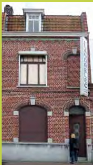
Vue d'une façade restaurée sur rue
