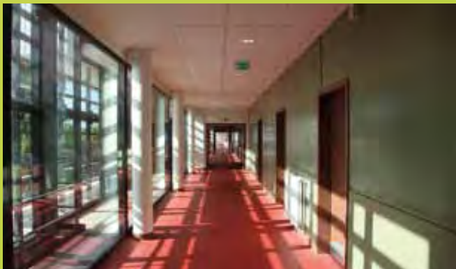
Vue de la circulation desservant les salles de classe, totalement protégée du bruit et de la chaleur par la double peau
