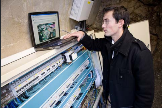
Citadelle de Sisteron – télégestion intégrale avec automate serveur WEB (photo© William Sanial).
