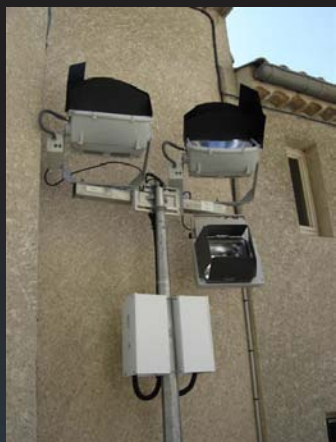
Citadelle de Sisteron - volets d'occultation des flux perdus (photo@Cerema)
