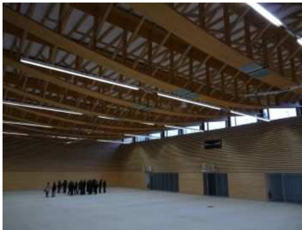
Vue sur le gymnase depuis les gradins Sud
