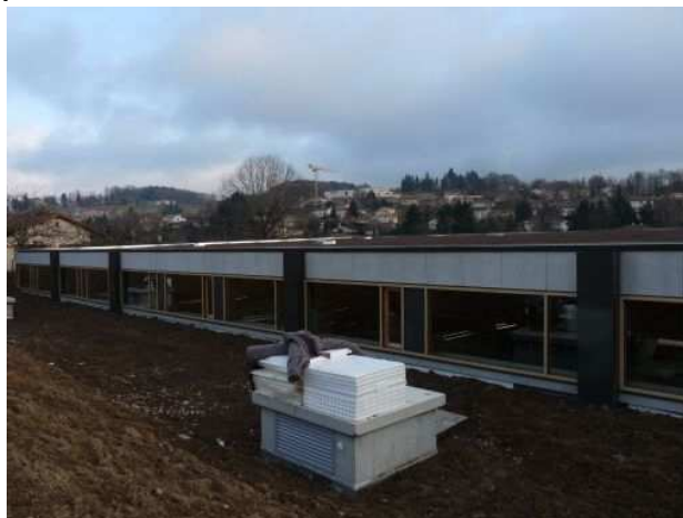
Bandeau lumineux au Nord et toiture végétalisée
