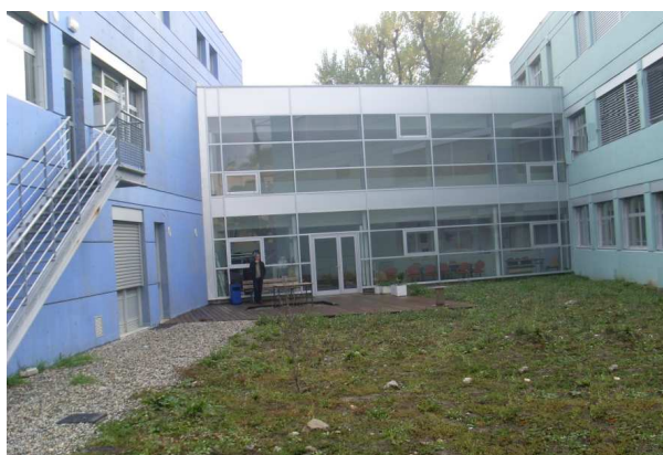
Vue sur patio entre le bâtiment A et B (orientation Nord)
