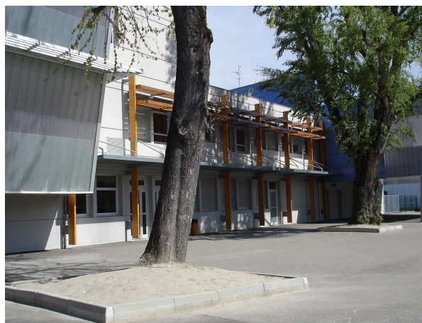
Vue de la façade sud depuis la cours
