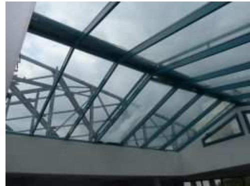
Verrière et surtoiture métallique
