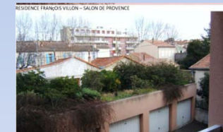
AGENCE SARS / TOITURE EXTENSIVE AVEC 30 A 40 CM DE TERRE VEGETALE SUR GARAGES. CONFORT VISUEL ET CONFORT D'ÉTÉ. MAIS SURCHARGE DE LA TOITURE A PRENDRE EN COMPTE EN CONCEPTION / STRUCTURE
