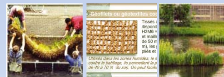
Fascines et Nattes et Géofilet, radeau végétalisé
