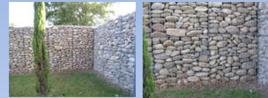
MUR EN GABIONS A AVIGNON
