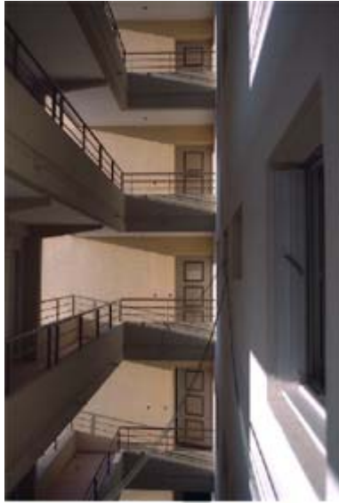
Immeuble REX HQE de Nice : Vue des coursives l'après-midi en été : effet d'ombre des coursives sur la façade OUEST des T2 : au fond, les entrées des T3.
