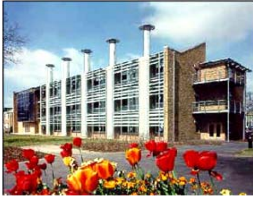
Fig. 20 – Façade du bâtiment du B.R.E. à Garston, UK, (d'après la fiche de « l'European Green Building Forum ») www.w-e.nl
