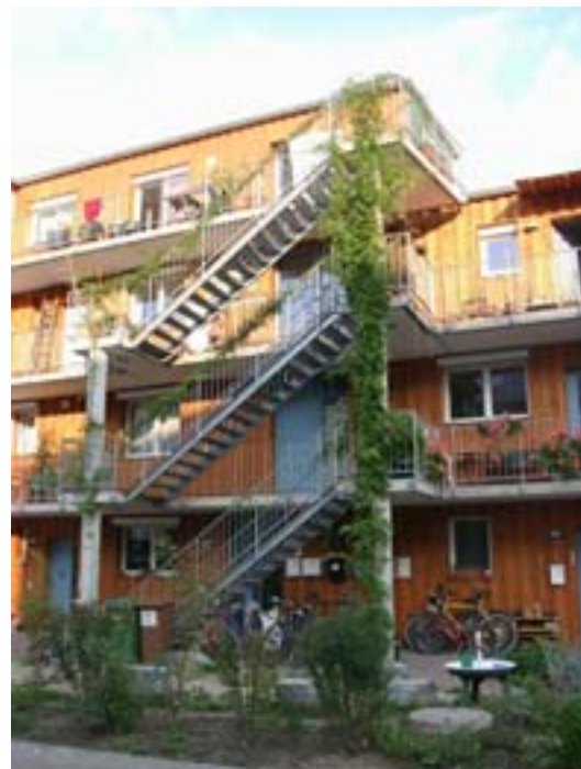
Coursives à Freiburg (à droite) : collées en façade NORD, desservent des simplex traversants.
