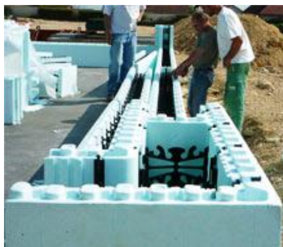
Mise en place des premières rangées de coffrage Nudura (source : fabricant Néobat)
