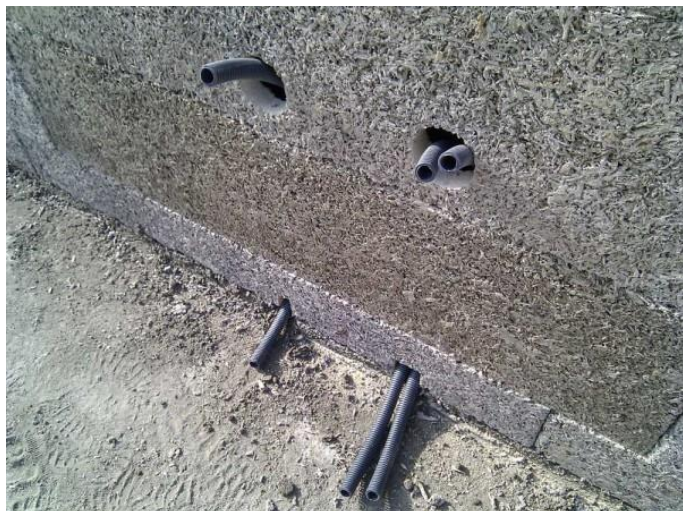
Mise en place des tuyaux dans le coffrage isolant bois/ciment (Source : Constructeur)
