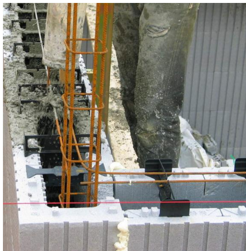
Coulage du béton dans le coffrage isolant PSE (Source : Constructeur)
