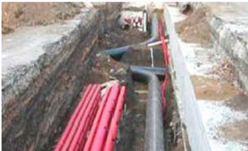
Système souterrain de collecte pneumatique (Source : http://www.22barcelona.com )
