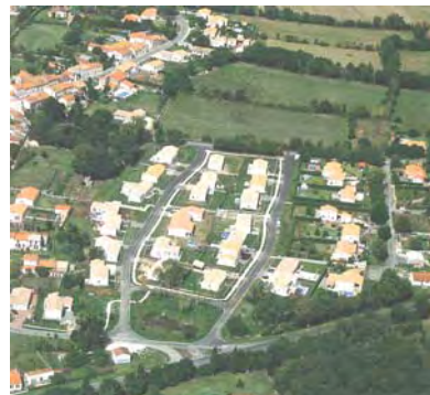
Lotissement Charente-Maritime Photo : Ecav-Aviation
