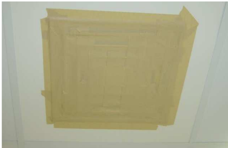
Calfeutrage d'une bouche de ventilation avec du ruban adhésif
