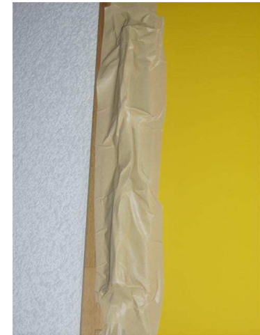
Calfeutrage des espaces entre les portes (2 ème porte de la salle donnant sur le couloir du bâtiment)
