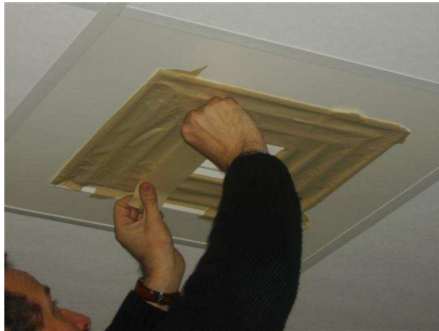
Calfeutrage d'une bouche de ventilation avec du ruban adhésif
