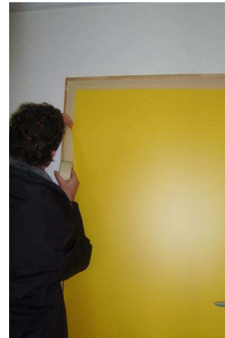
Calfeutrage des espaces entre les portes (2 ème porte de la salle donnant sur le couloir du bâtiment)
