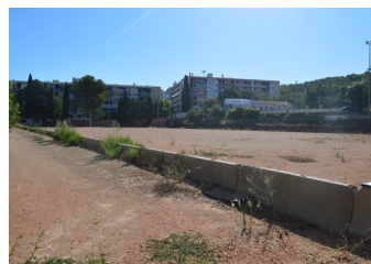
90m de GBA en béton
