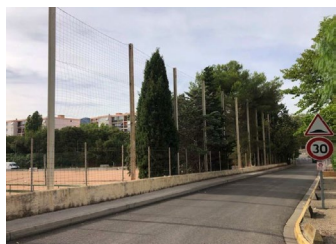
Clôtures + poteaux métalliques
