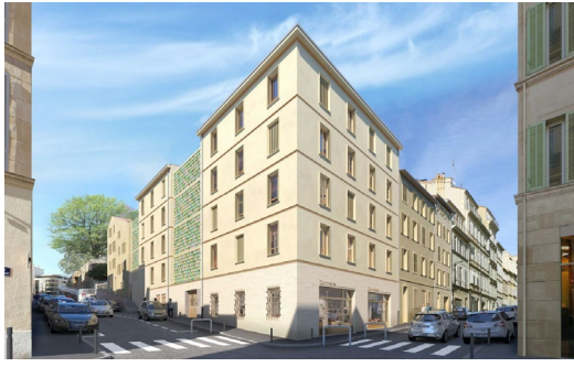
Projet Vue par la rue-d'Isoard/rue De Bernardy
