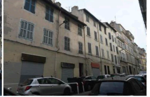
Fig.6 – Photographie de la façade Sud de la résidence Le Californie – Avril 2022
