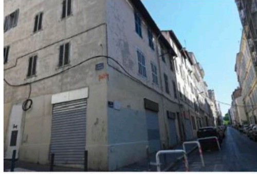
Fig.5 – Photographie de l'angle entre la façade Ouest et la façade Sud de la résidence Le Californie – Avril 2022
